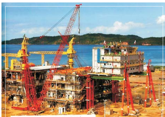
[ O módulo já içado e pronto para deslizar lateralmente ]
